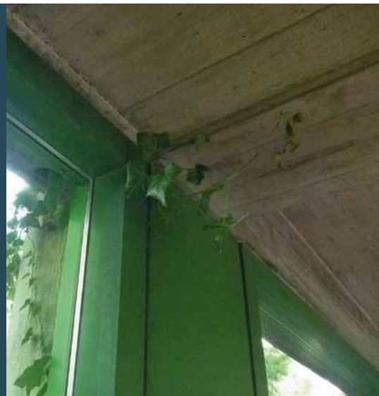
Efeu – Innenbewuchs von Außen
