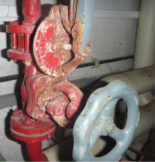
Absperrschieber, Heizungsvorlauf/Wärmebänke
