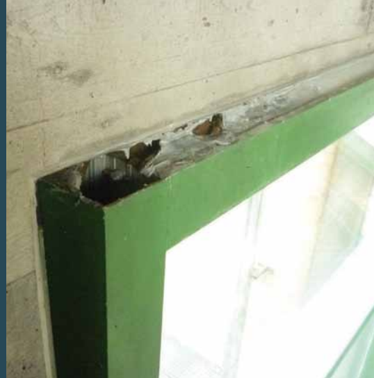
Undichte Fensterrahmen
